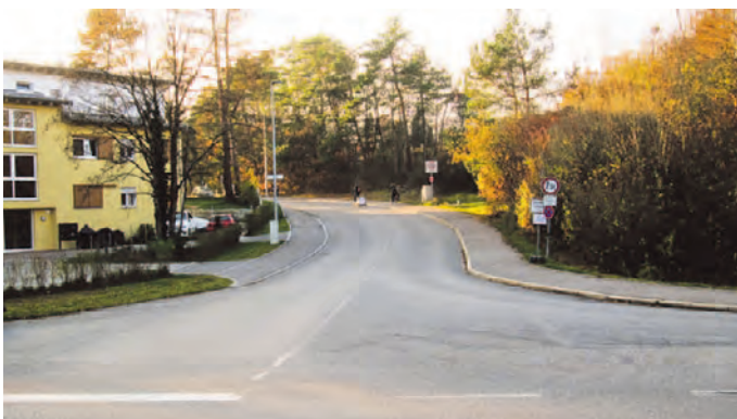
Die Querung der Senserbergstraße soll für Fußgänger und Radler sicherer werden.
