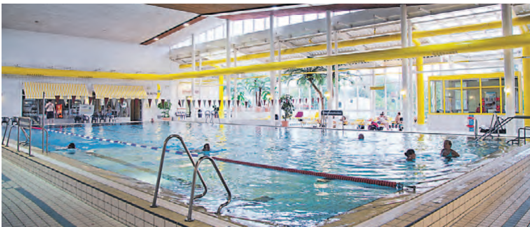
Auf den ersten Blick sieht das Hallenbad recht proper aus, doch offenbar muss in den kommenden Jahren einiges an Geld investiert werden. // Foto: Stadtwerke FFB
