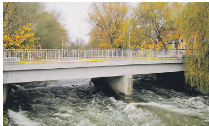
Die neue Brücke wird keinen Mittelpfeiler mehr haben.
